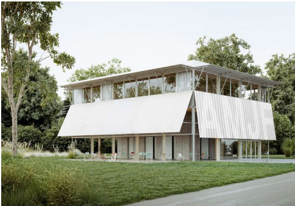
L'ancienne maison des jardins familiaux (AMJF) est le cœur du projet. En effet, les volumes sont reliés dans l'axe nord-sud, et la construction historique redonne la façade de la maison de quartier.
